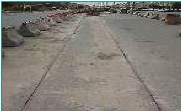
الشكل (1): قص طبقات الرصف الأسفلتي.
