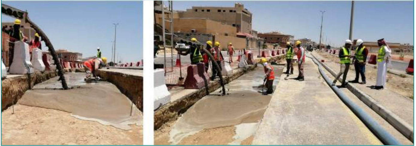
الشكل (3): وضع طبقة مواد (الخرسانة الرغوية)
