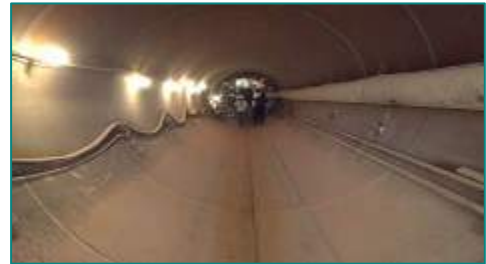
تقنية دفع المواسير ماسورة من الصلب بداخلها بريمة الحفر
