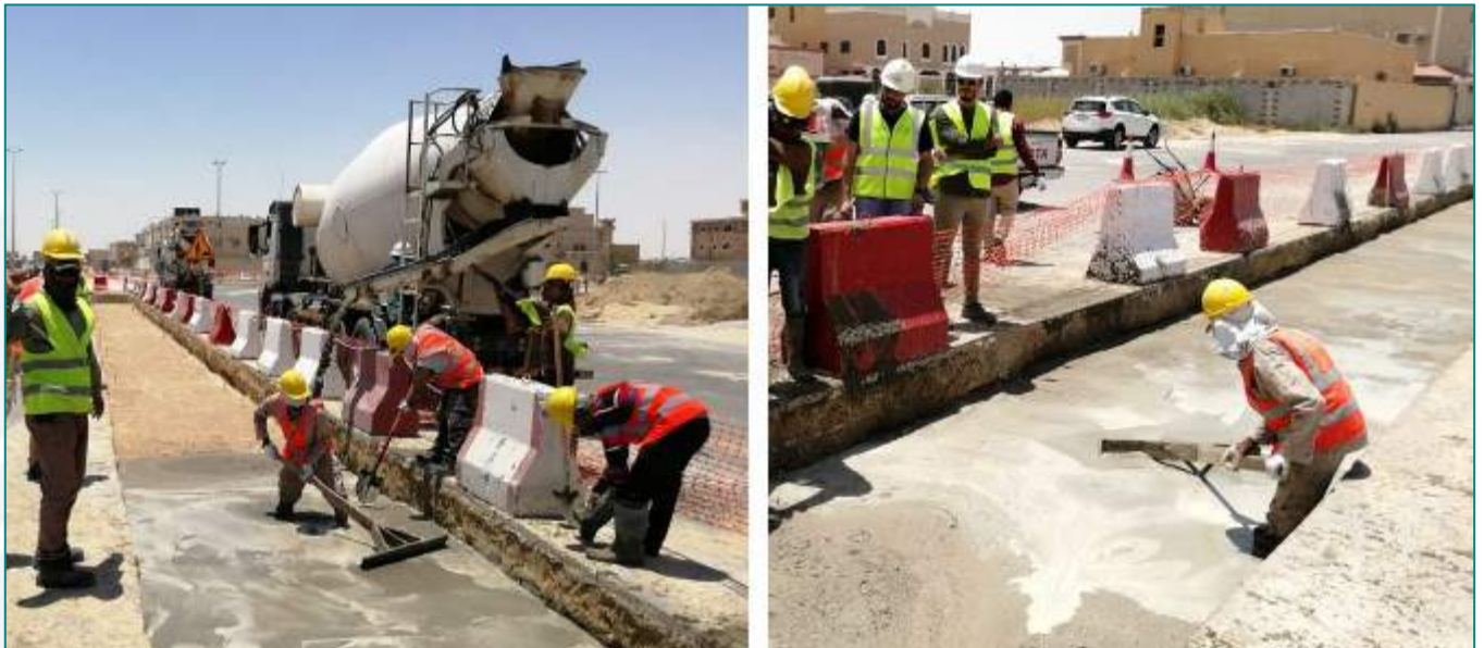
الشكل (4): تسوية طبقة (الخرسانة الرغوية)
