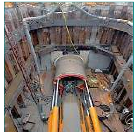
تدعيم جوانب حفرة الانطلاق بألواح الصلب Sheet Piles
