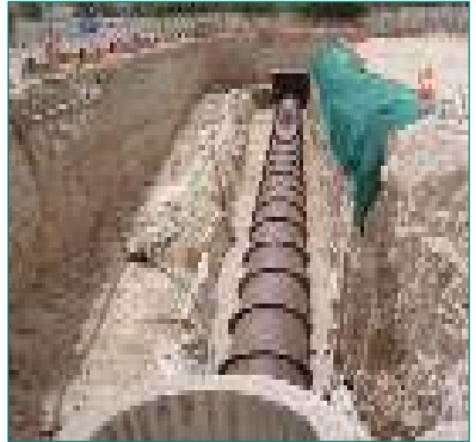
حالة تمديد مرفق وطبقة الحماية له في حفر مفتوح
