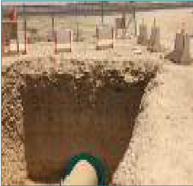
حالة تمديد مرفق وطبقة الحماية له في حفر مغلق
