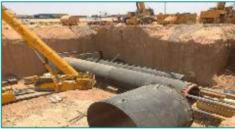
دفع المواسير بالمكابس الهيدروليكية
