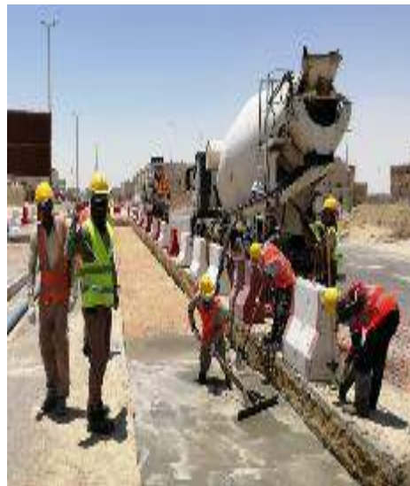
الخرسانة الرغوية لردم الحفريات
