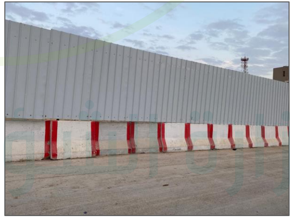
شكل رقم (13): تنفيذ خاطئ لسور مؤقت من المصدات الخرسانية ومواد غير الهنجر
