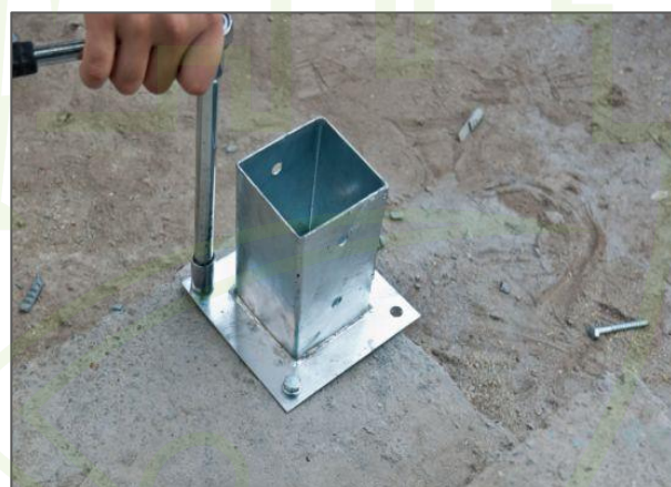
شكل رقم (14): قواعد المنيوم وتيوبات حديد لتثبيت أعمدة السور المؤقت
