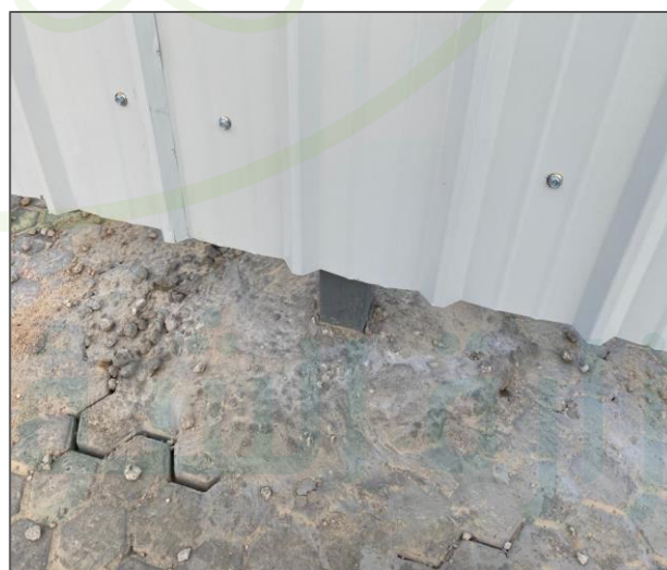
شكل رقم (15): تثبيت خاطئ لأعمدة السور المؤقت
