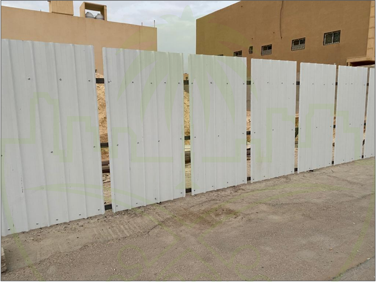
شكل رقم (12): تنفيذ صحيح لسور مؤقت من الألمنيوم الأبيض
