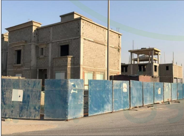
شكل رقم (13): تنفيذ خاطئ لسور مؤقت من المصدات الخرسانية ومواد غير الهنجر
