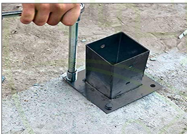
شكل رقم (14): قواعد المنيوم وتيوبات حديد لتثبيت أعمدة السور المؤقت
